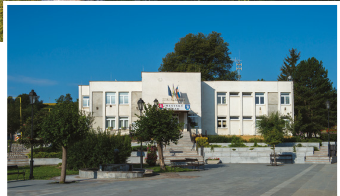
Budynek Urzędu Miasta Budova mestského úradu City Hall
