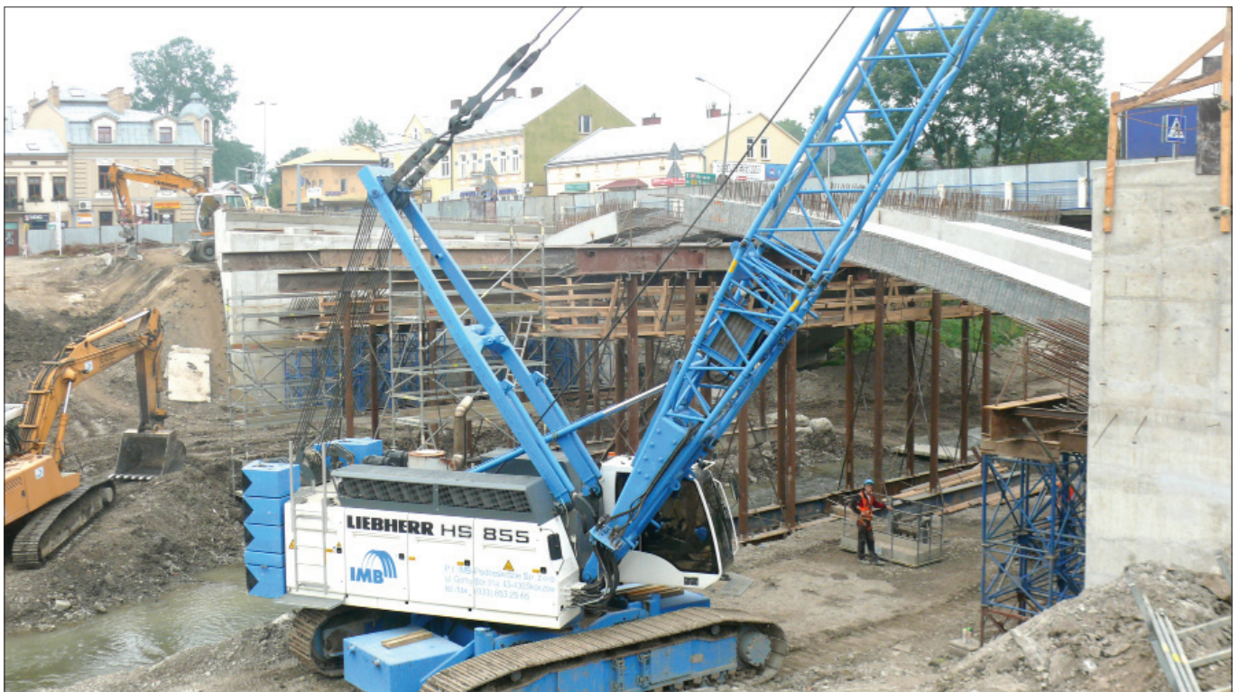
Montaż konstrukcji łukowej mostu
