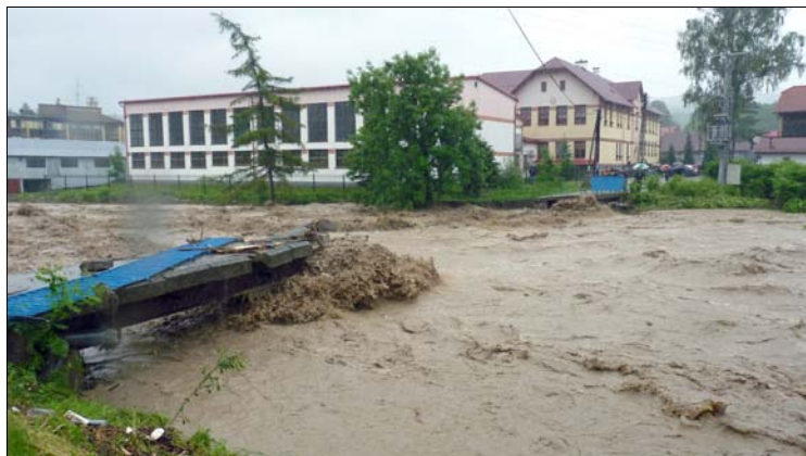
Zerwana kładka dla pieszych przy ZSZ
