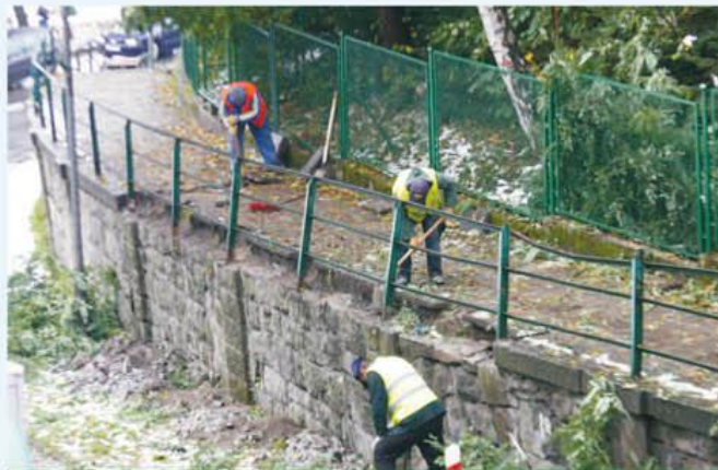
Rozpoczęcie prac remontowych przy DK-28
