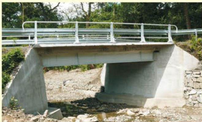
Wyremontowany most na Strzylawkach
