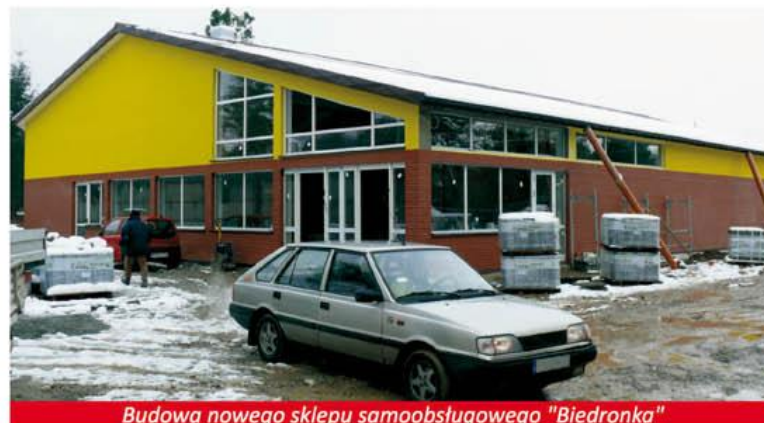
Budowa nowego sklepu samoobsługowego "Biedronka"
