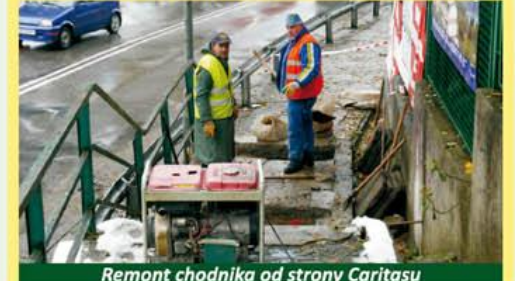
Remont chodnika od strony Caritasu
