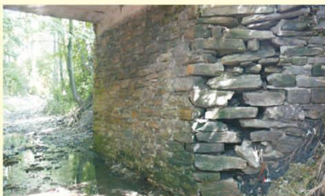
Most do remontu przy ul. Chłodnej
