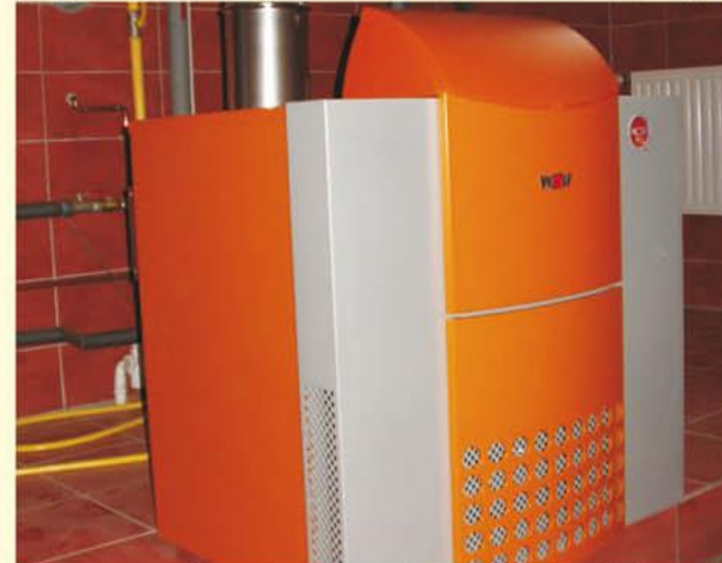
Nowy piec grzewczy i wyremontowana kotłownia
