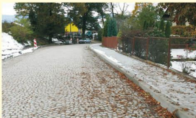
Fragment ul. Kolejowej z odcinkiem nowej kanalizacji
