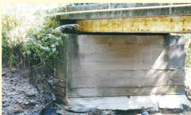
Most do remontu na Pławiance
