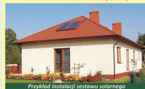
Przykład instalacji zestawu solarnego
