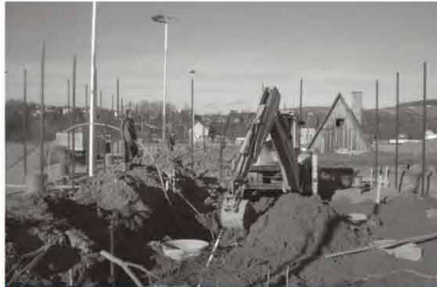
Instalacja przyłącza energetycznego
