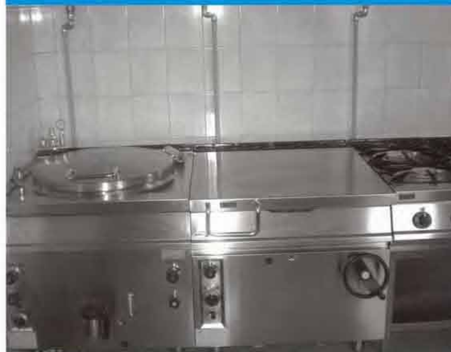
Rozbudowa zaplecza kuchennego
