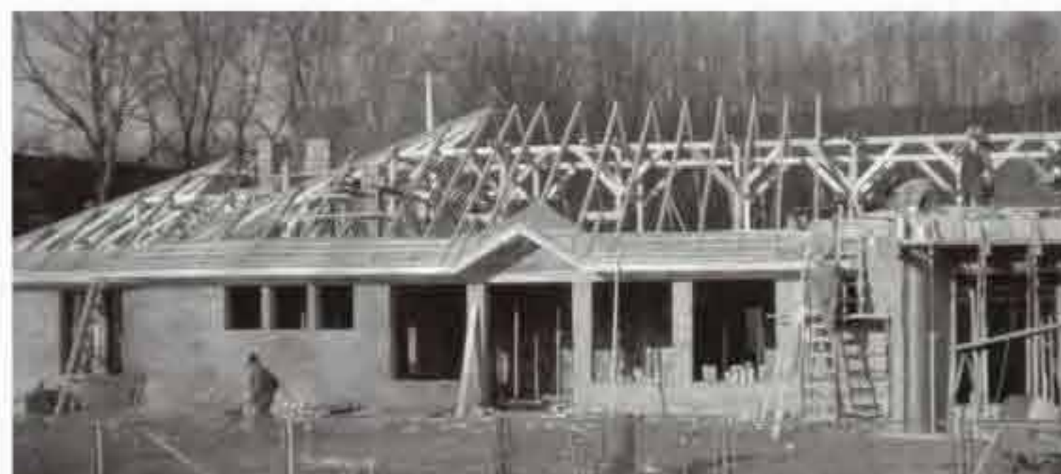
Budowa nowego przedszkola
