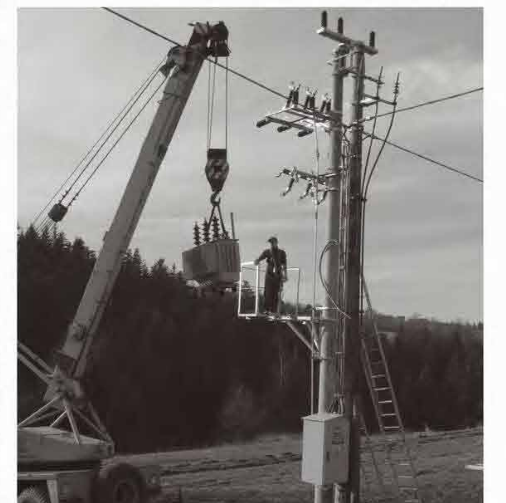
Montaż nowego transformatora
