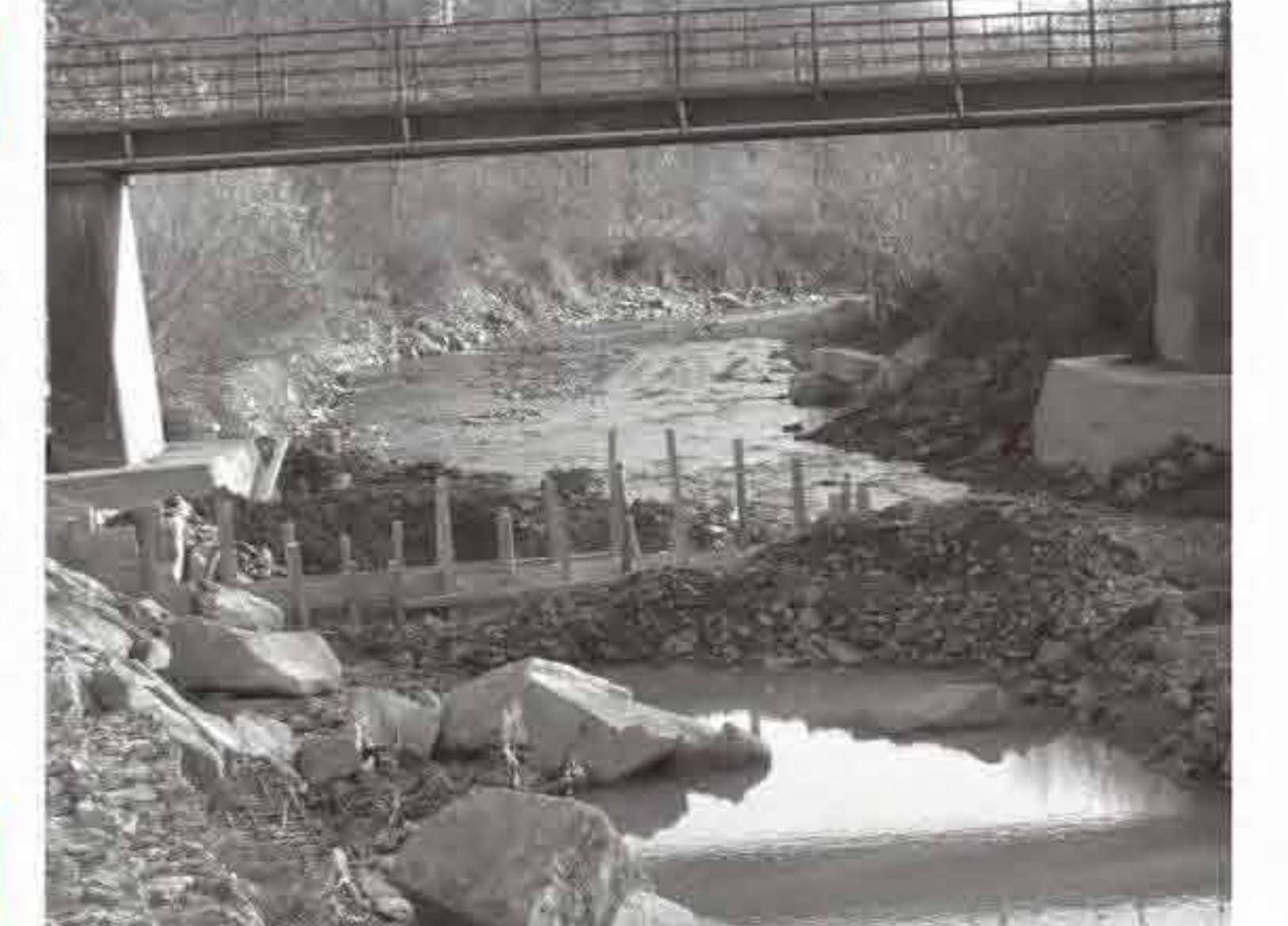
Remont mostu wykonany przez firmę "Usługi -Drogowo Budowlane" z Nowego Sącza
