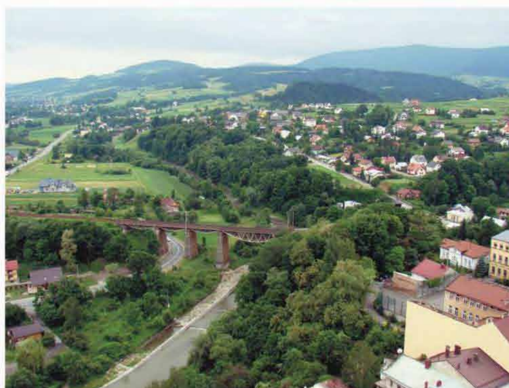
Most kolejowy - jak zabawka
