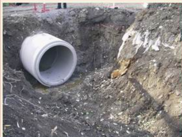
▲ Wymiana przepustu, Sośnie Dolne
