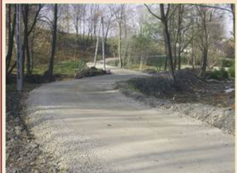
▲ Naprawa drogi, Sudoł
