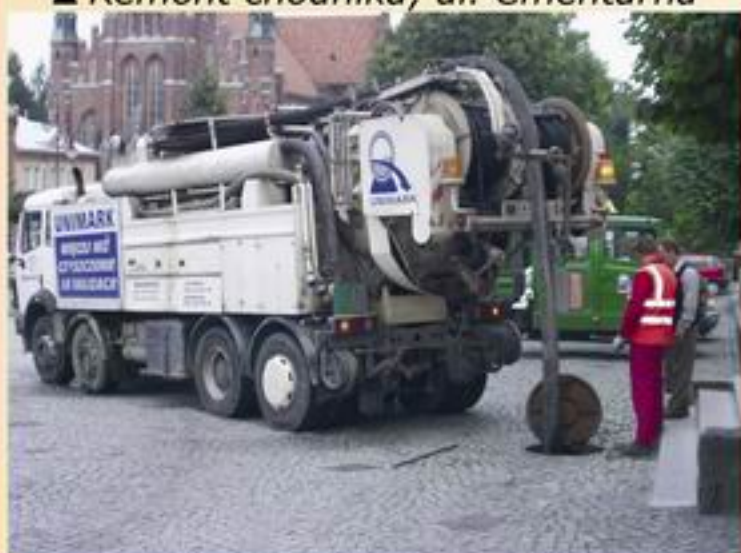
▲ Czyszczenie kanalizacji burzowej
