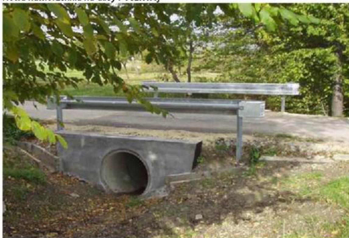
Wyremontowany przepust drogowy na ulicy Sośnie Górze
