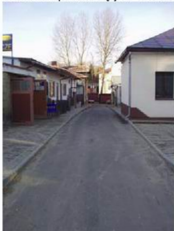
Nowa nawierzchnia na ulicy Pocztovej
