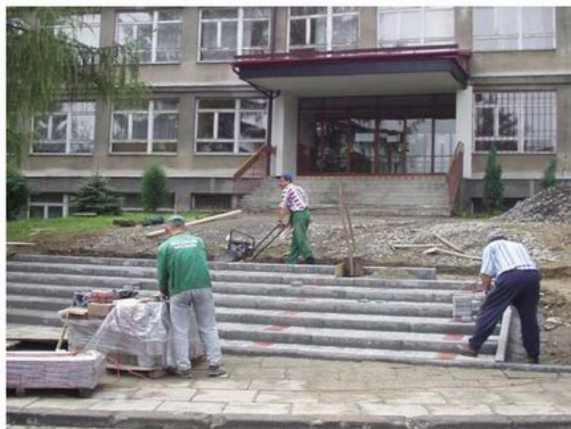
Remont schodów, Szkoła Podstawowa Nr 1
