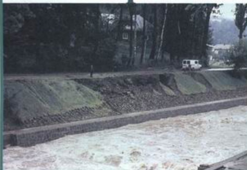
Zniszczenia na ul. Topolowej
