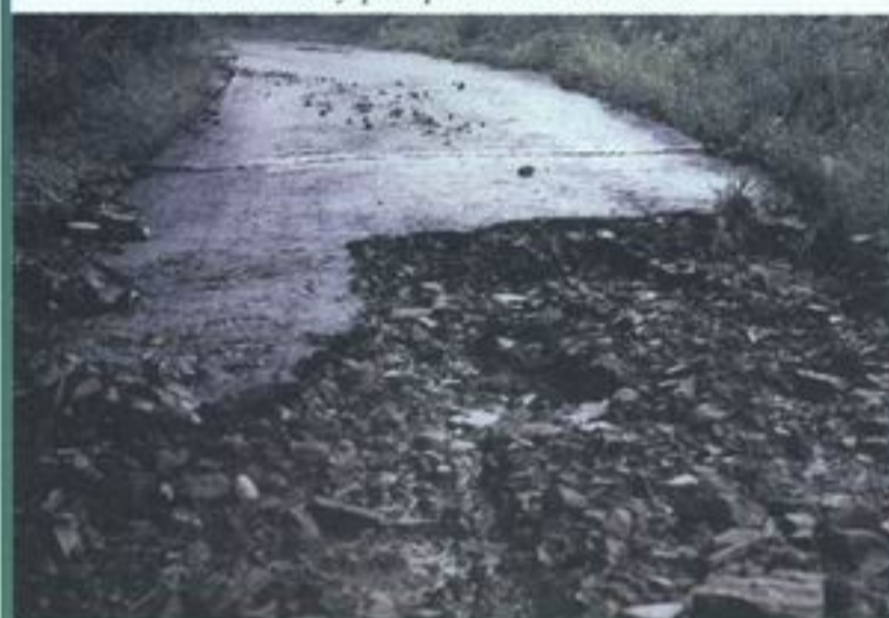
Uszkodzenie drogi asfaltowej na Oś. Sośnie
