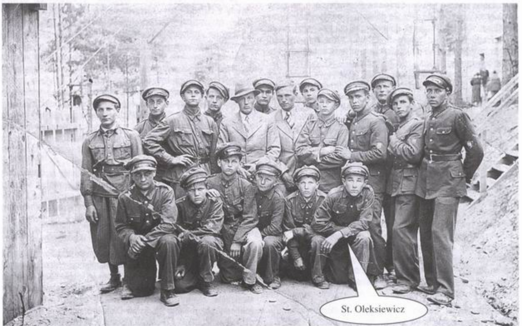
Grupa Strzelców z 1938 roku na budowie zapory w Rożnowie
