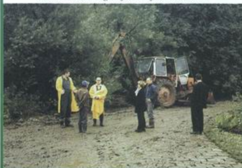
Zniszczona nawierzchnia drogi na Oś. Strzylawki
