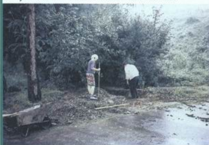
Zamulony przepust na Oś. Sośnie
