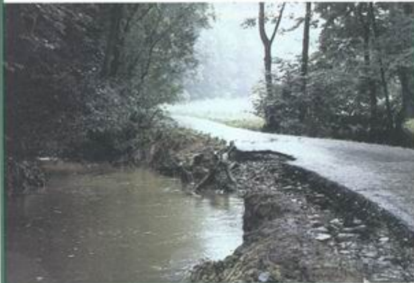
Podmycie drogi dojazdowej przez potok Sudol na Oś. Sośnie
