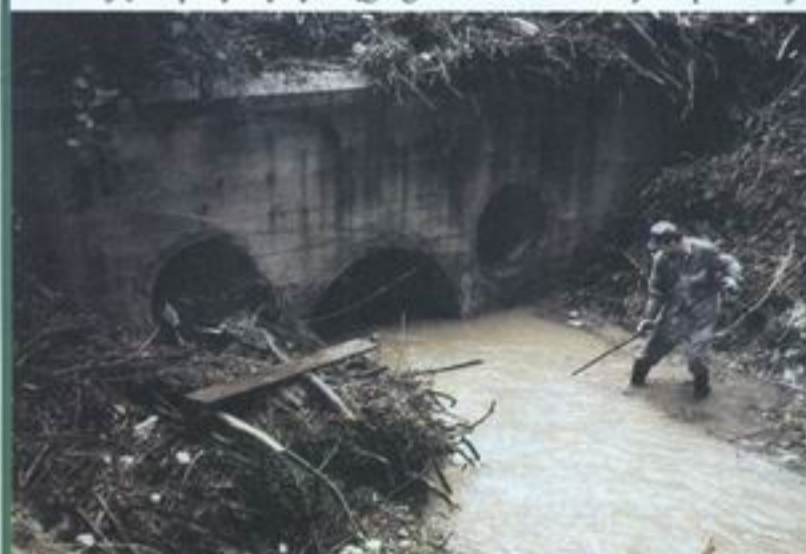
Prace związane z udrożnieniem przepustów na potoku Wikle, których to niedrożność była bezpośrednią przyczyną zalania budynku parafialnego i ul. Topolowej
