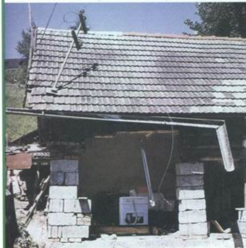
Zniszczony dom mieszkalny w miejscowości Korzenna Burmistrz Miasta – Piotr Piechnik
